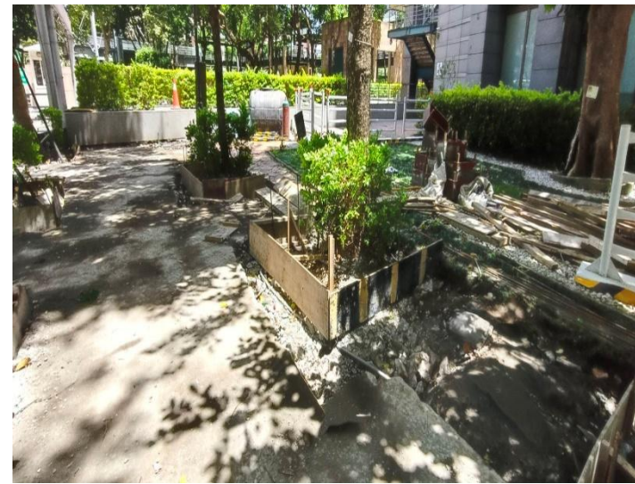
新府路第二階段樹穴模板組立
