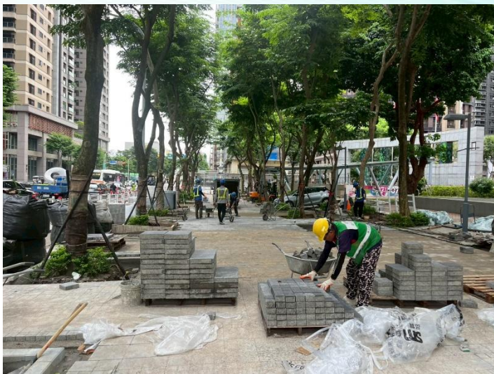
新站路第二階段高壓磚施作
