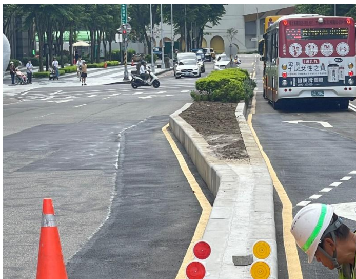
新站路分隔島削減完成
