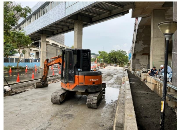
人行道結構及外側回填
