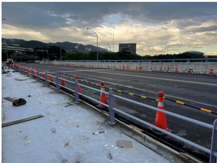
防護欄杆與基礎施作
