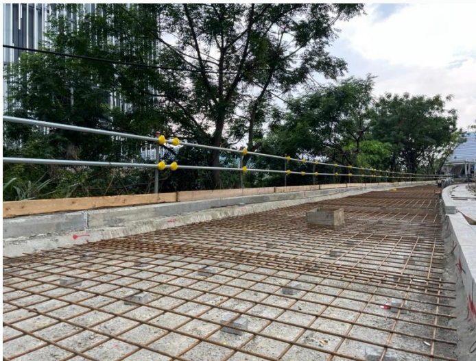
避車彎人行道結構施作
