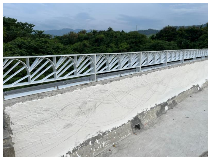
造型帆影欄杆安裝
