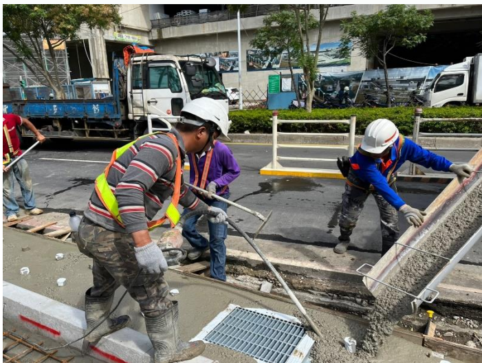
捷運空橋段側溝施作
