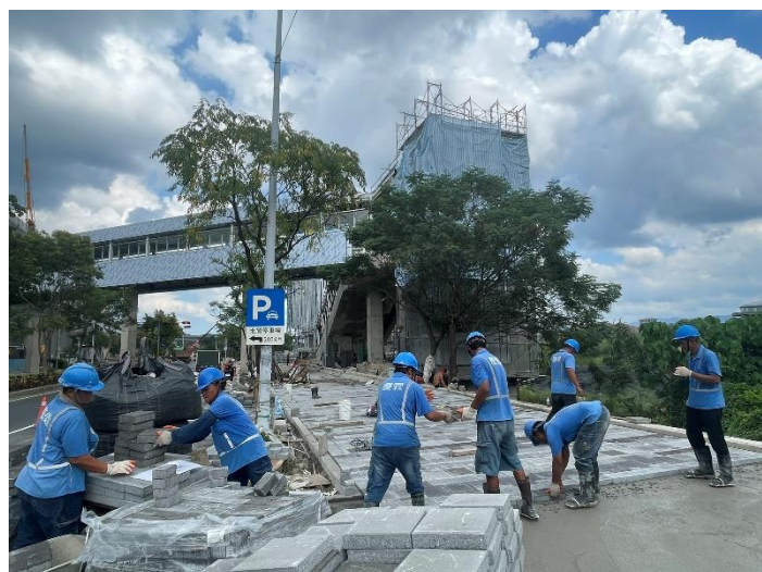
環保高壓磚鋪設
