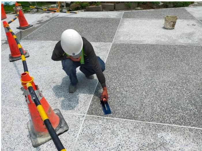
斜坡道振石子
