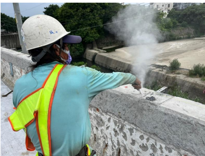
造型帆影欄杆螺栓預鑽孔
