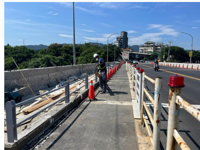
防護欄杆安裝校正
