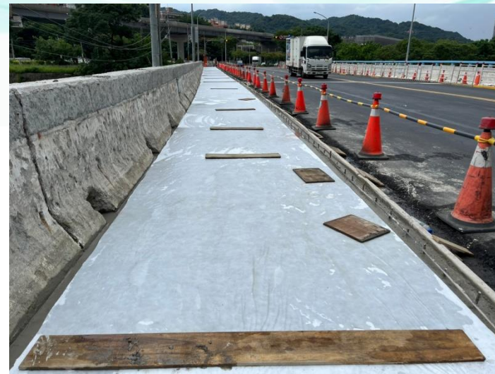
噴花地坪結構混凝土養治
