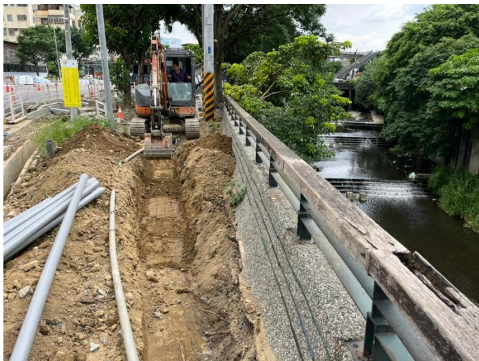
弱電管溝施作
