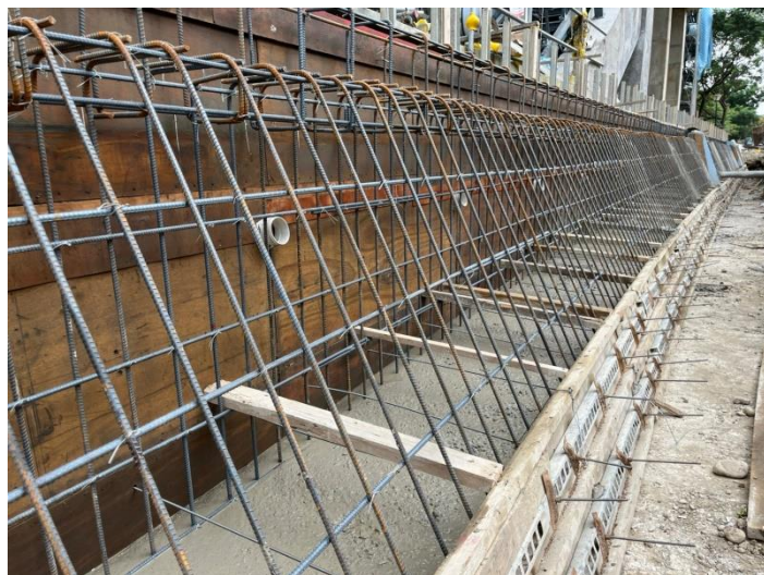
第一升層模板組立與灌漿
