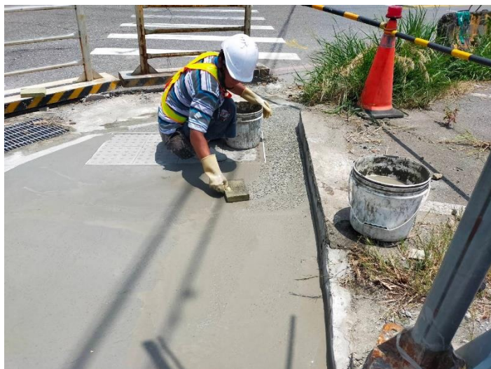
斜坡道振石子
