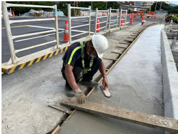
路口洩水板施作
