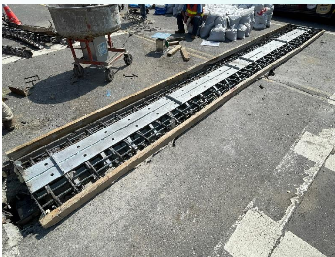
伸縮縫安裝與配筋
