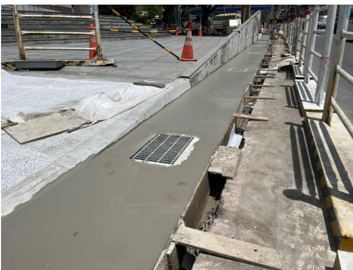
陶博館前側溝蓋施作
