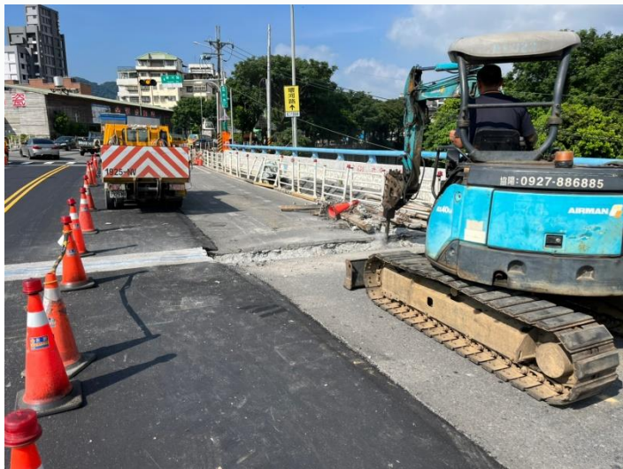
南靖橋既有伸縮縫拆除
