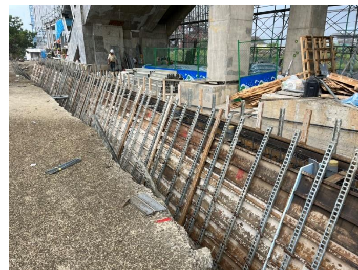
模板組立完成
