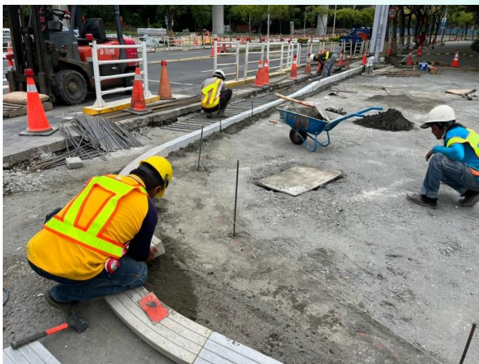
路口斜坡道施作
