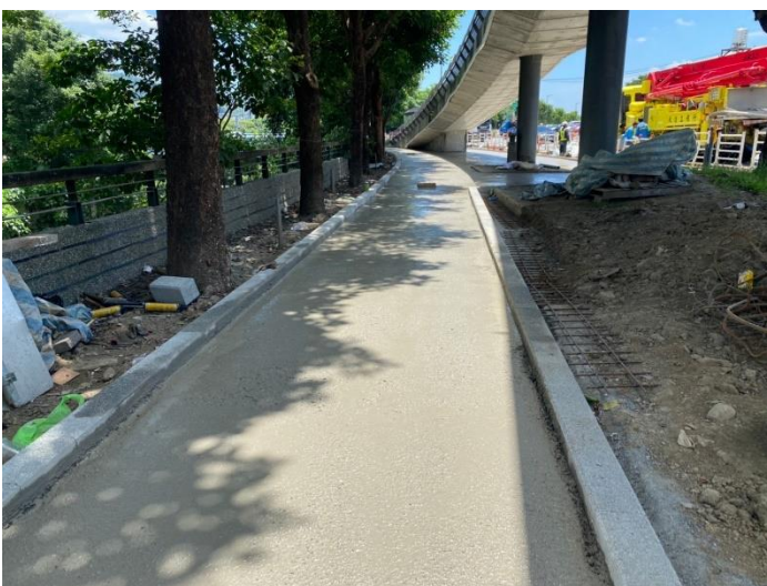
結構層混凝土澆置
