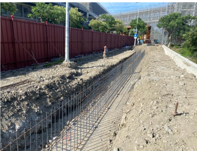
避車彎側溝鋼筋組立
