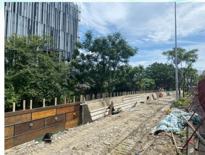
新設擋土牆造型模組立
