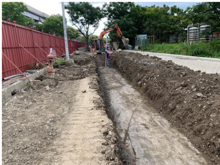
避車彎側溝開挖
