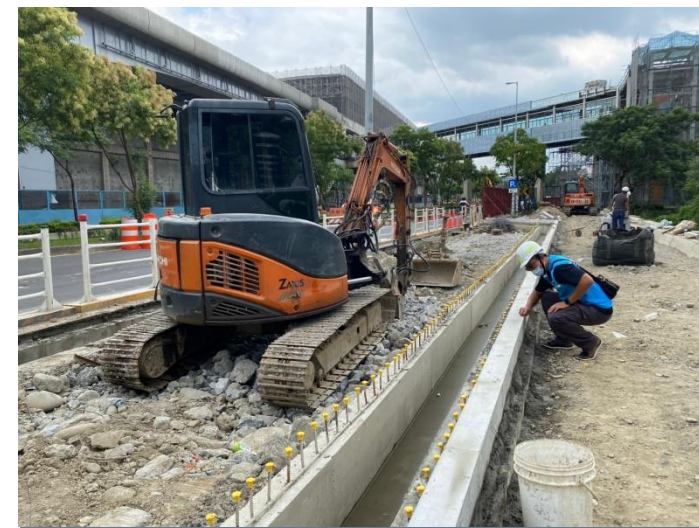
避車彎側溝牆施作
