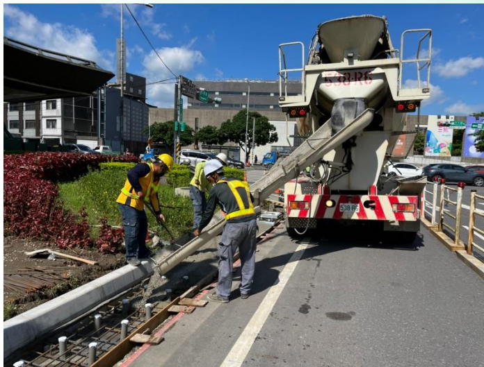
溝蓋板混凝土澆置
