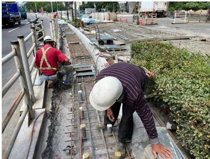
側溝溝蓋板施作
