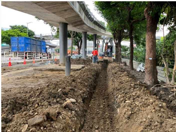
弱電管溝開挖
