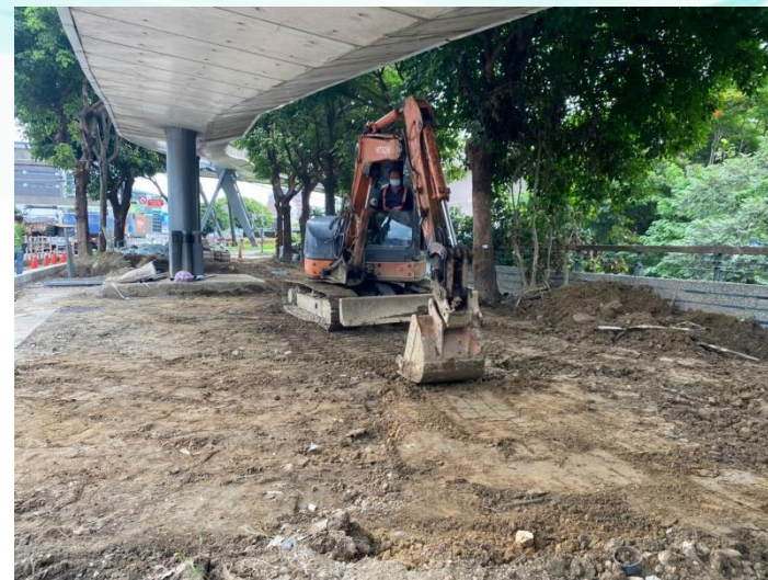
管溝回填後夯壓整平
