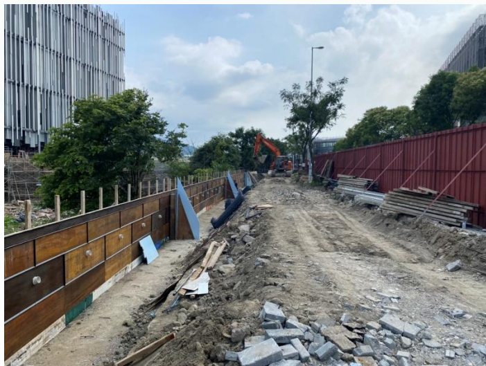
圍籬拆除及再生級配整理
