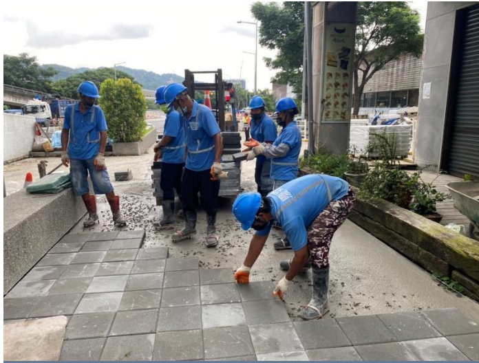
環保高壓磚鋪設
