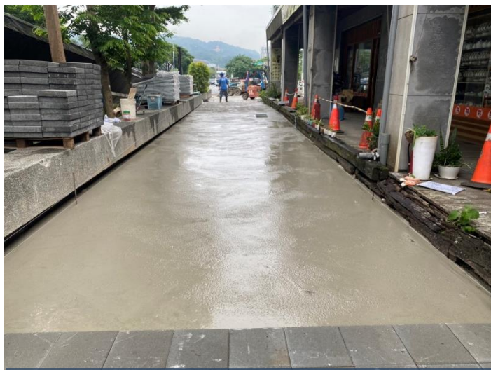
磚面水泥砂漿底層
