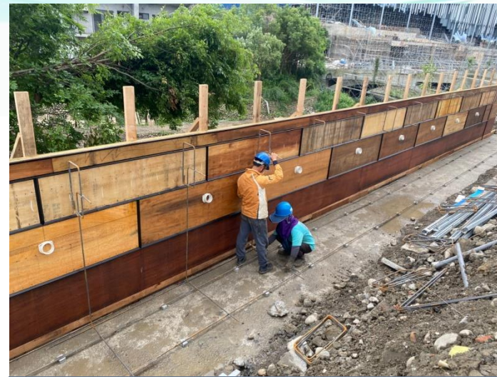
新設擋土牆造型模組立
