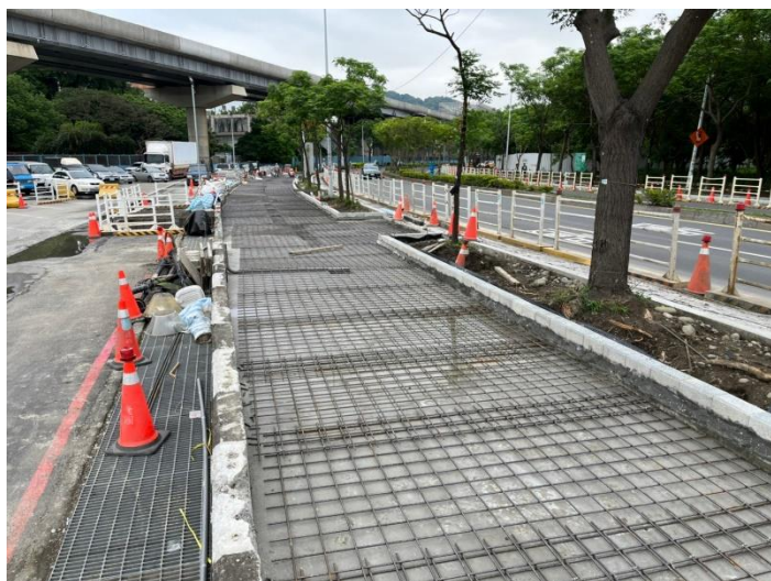
人行道結構層銲接網鋪設
