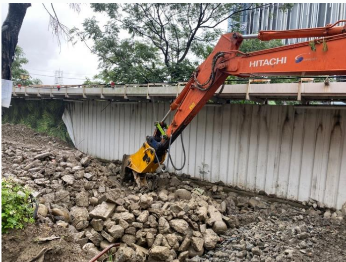
圍籬拆除及再生級配整理
