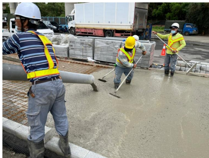
人行道結構層混凝土澆置
