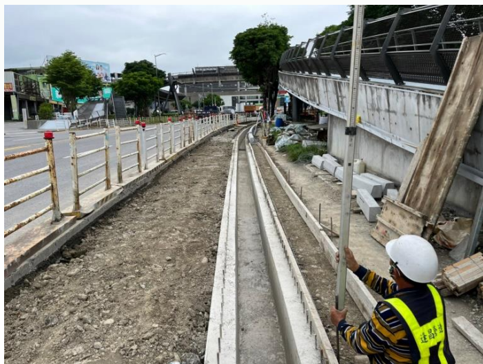
新設側溝高程測量
