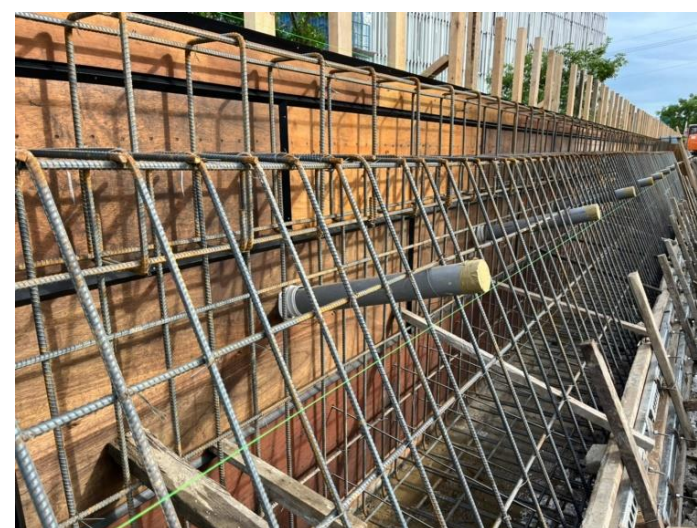
新設擋土牆洩水管安裝
