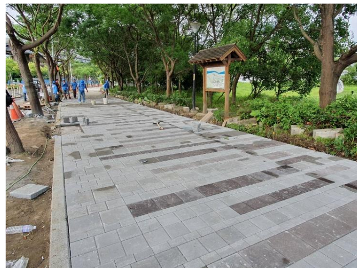
人行道環保高壓磚鋪設
