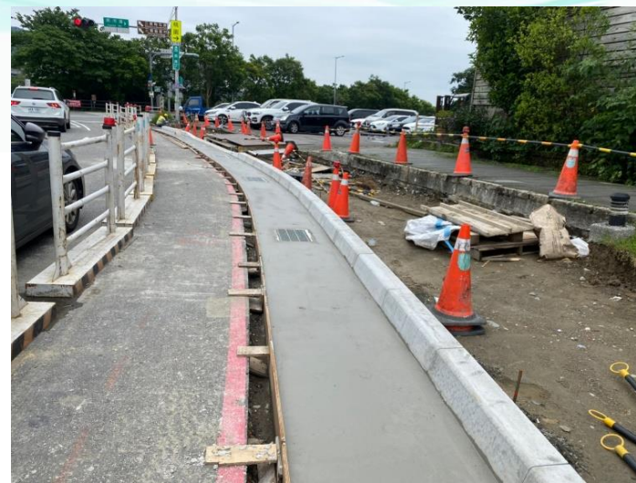
側溝溝蓋板混凝土澆置
