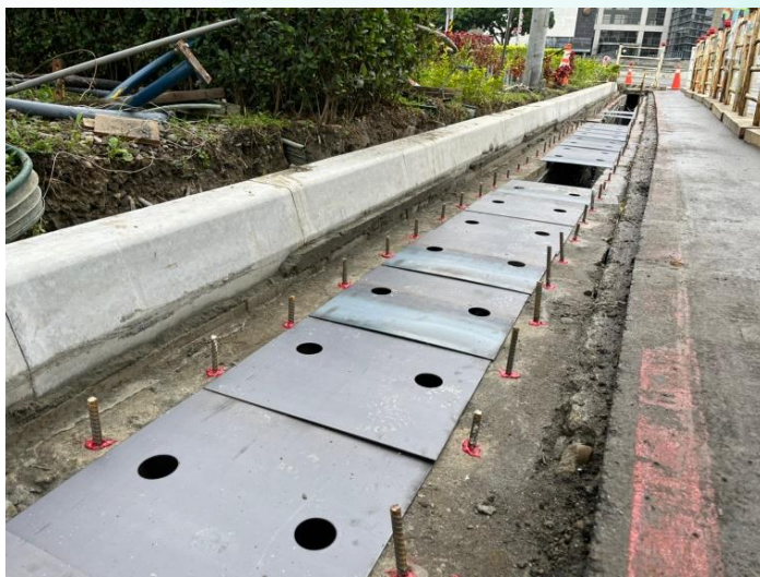
側溝溝蓋板鑽孔植筋
