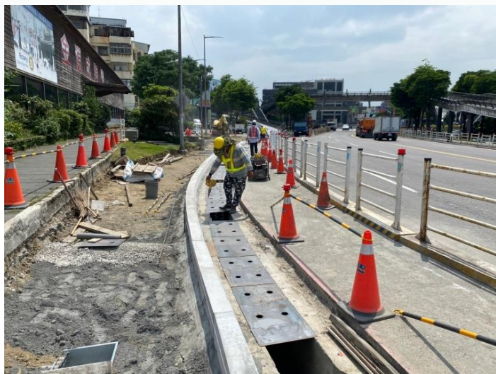
側溝溝蓋板免拆模板鋪設
