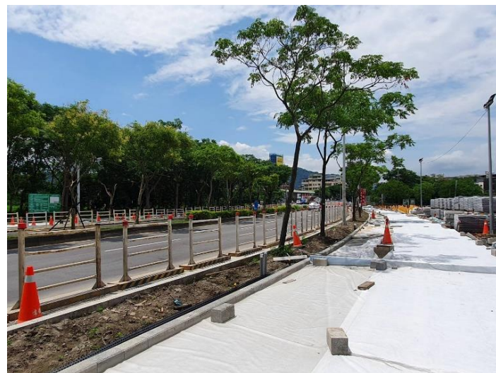
人行道結構層覆蓋養護
