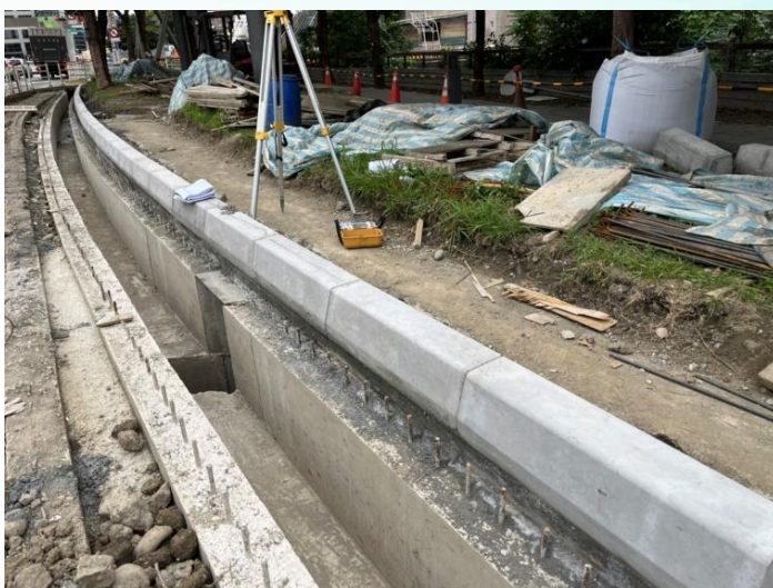
新設側溝頂板及緣石排放
