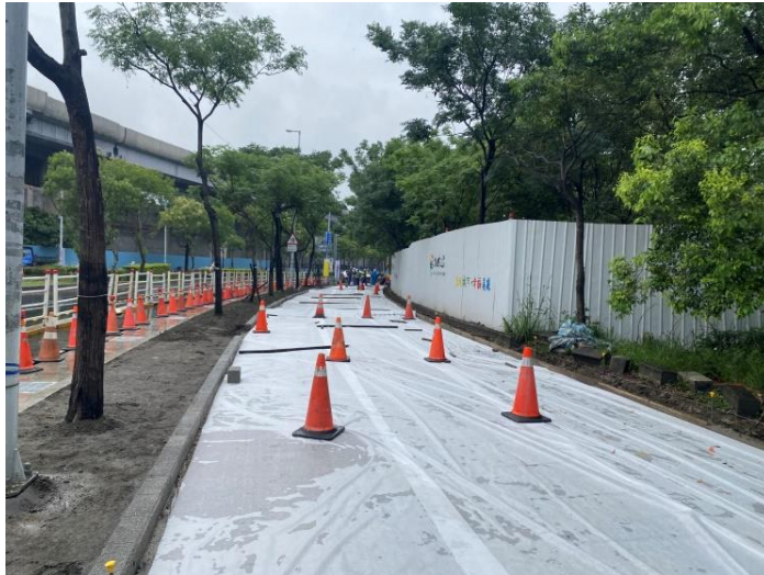
人行道結構層覆蓋養護
