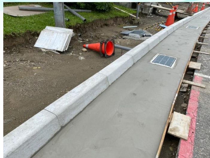
新設側溝施作完成
