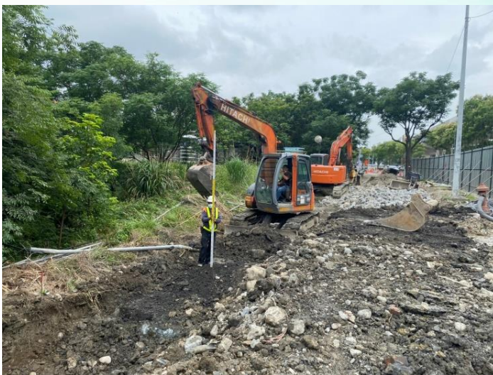
新設擋土牆基礎開挖
