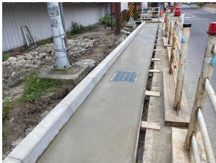
側溝溝蓋板混凝土澆置
