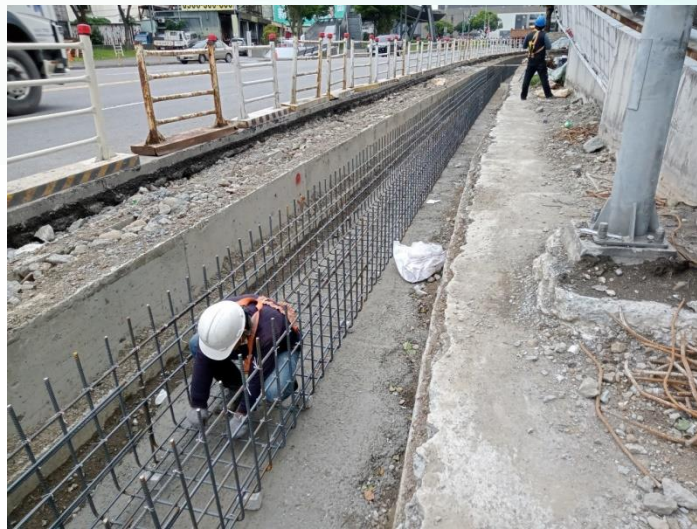
新設側溝鋼筋綁紮
