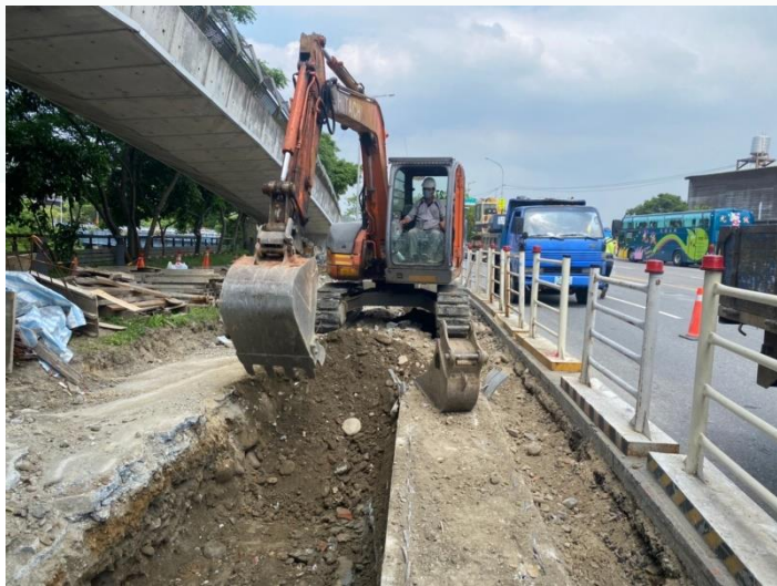
新設側溝開挖
