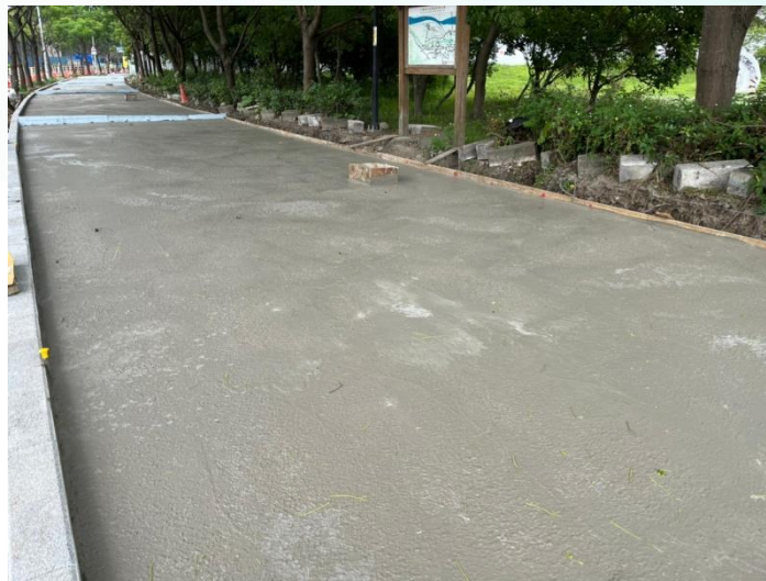
人行道結構混凝土澆置
