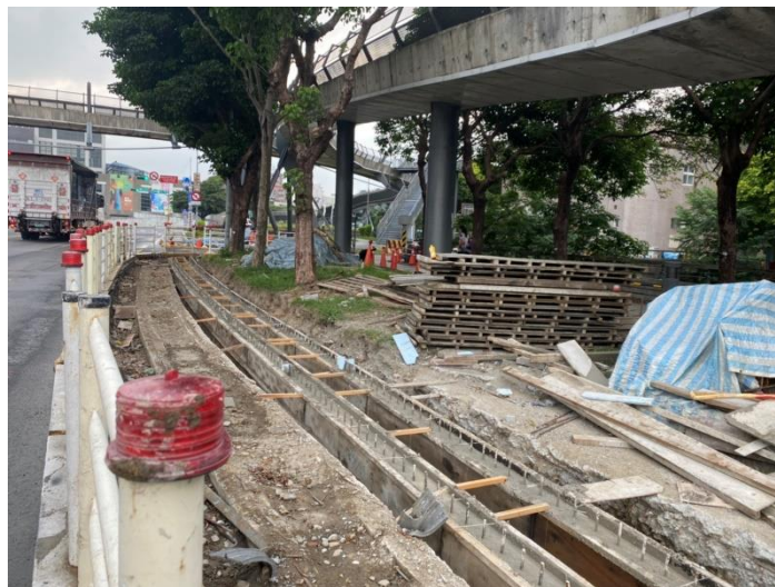
新設側溝混凝土澆置
