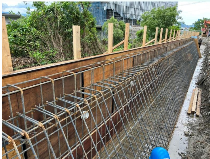
擋土牆鋼筋綁紮
