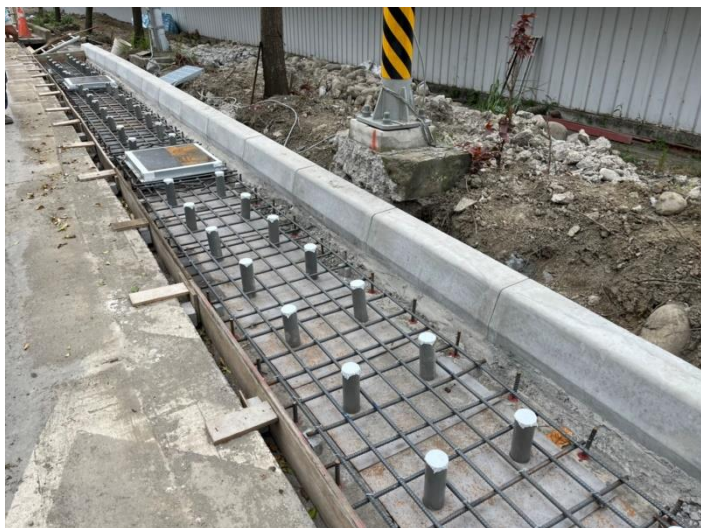
側溝溝蓋板施作
