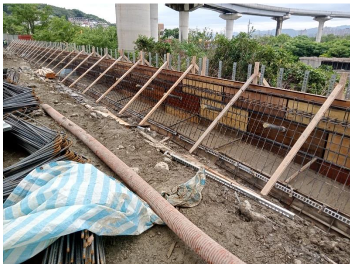
擋土牆基礎澆置
