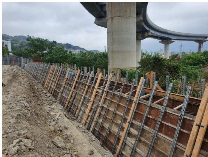
擋土牆結構澆置
