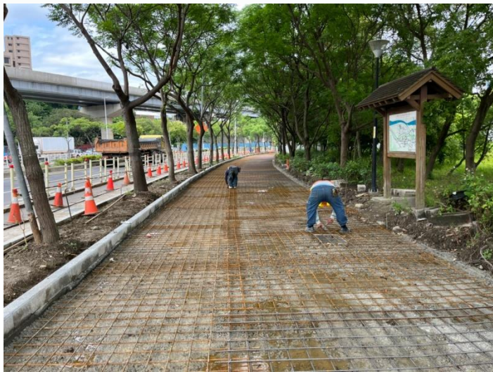
人行道結構施作
