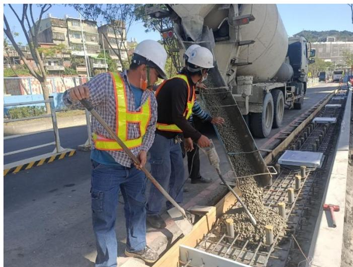
溝頂板混凝土澆置
