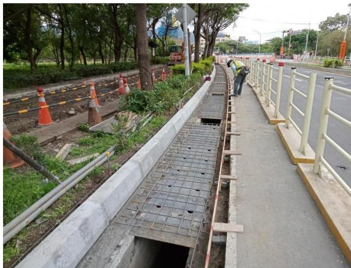
溝頂板鋼筋綁紮與模板
