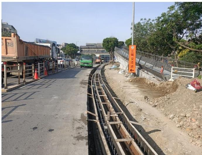
側溝鋼筋綁紮與模板組立
