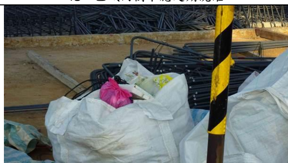
生活垃圾應集中處理於每日下工後帶離工區
