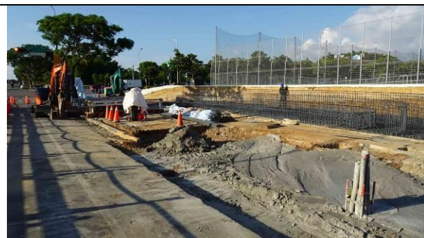
環境照-施工區域
