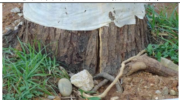
移植樹木根領處已開裂
