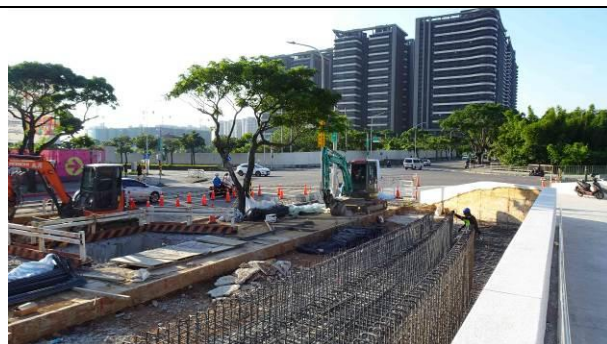
環境照-施工區域
