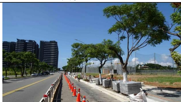
環境照-施工區域
