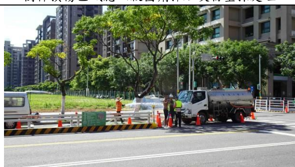
施工區域內樹木應定期澆灌
