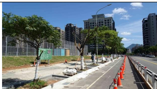
環境照-施工區域
