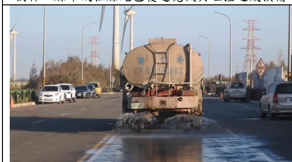
不定期於施工動線灑水
