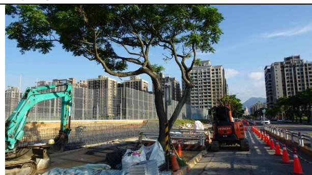
環境照-施工區域
