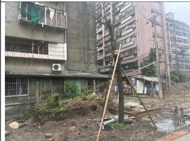
建議在樹幹上包裹稻草，以有效保護樹木免受外力撞擊和損傷。
