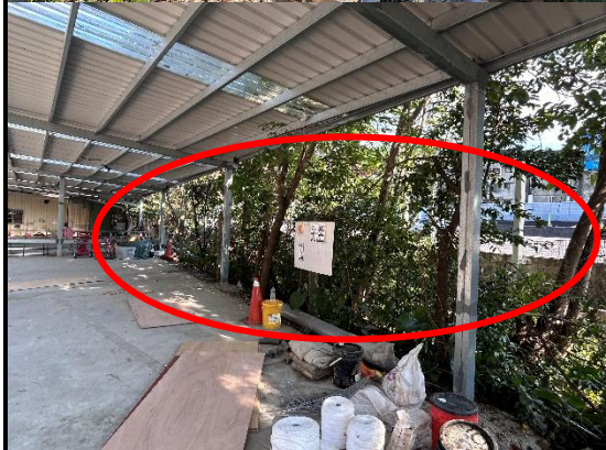
4.工區中的土方暫置區建議可使用防水布或防塵網覆蓋，可防止沙塵被強風吹起。
