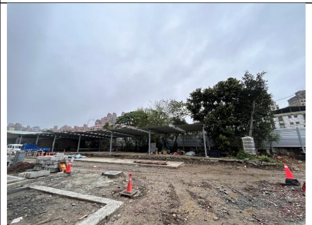
工程施作時須迴避湖前街二巷側之樹林。
