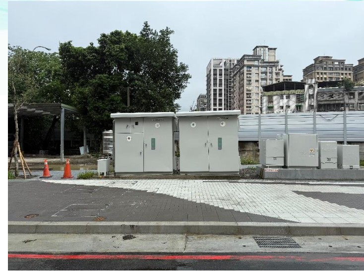
變電箱油漆完成
