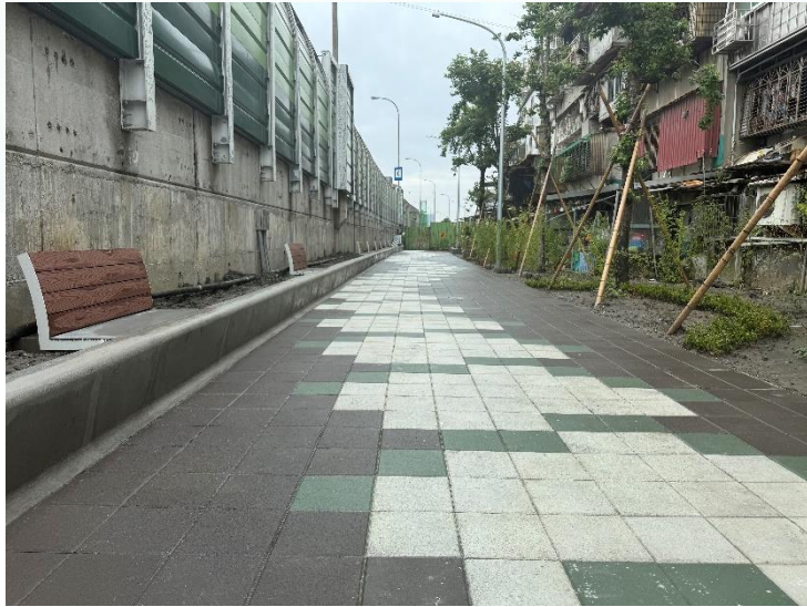
人行道鋪設完成
