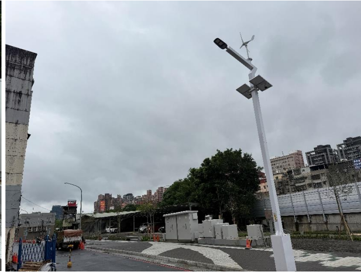
智慧共桿安裝完成
