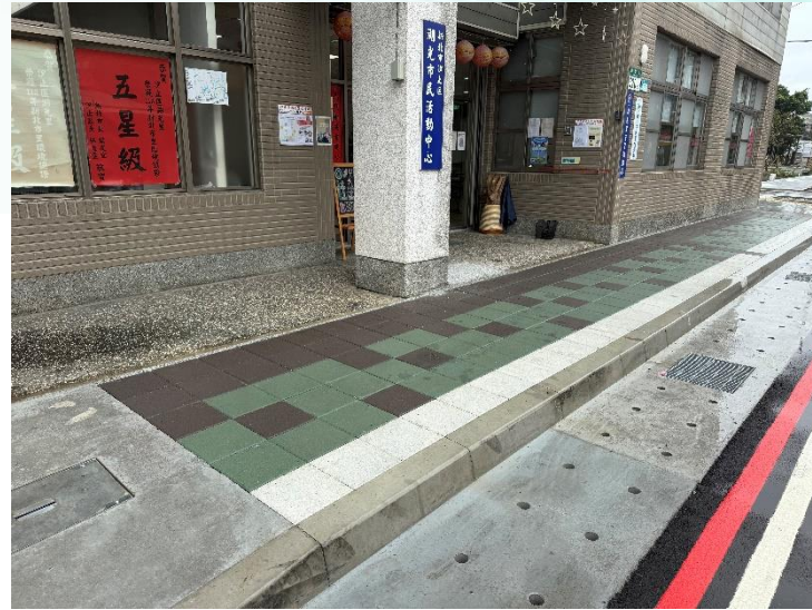
人行道鋪設完成
