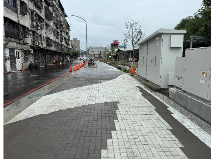
人行道鋪設完成
