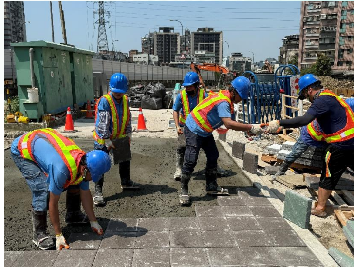
A0K+200~260高壓磚鋪設
