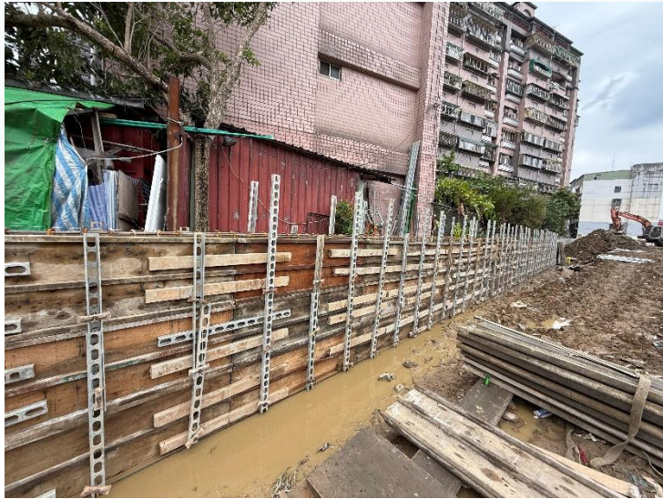
停車場擋土牆施作
