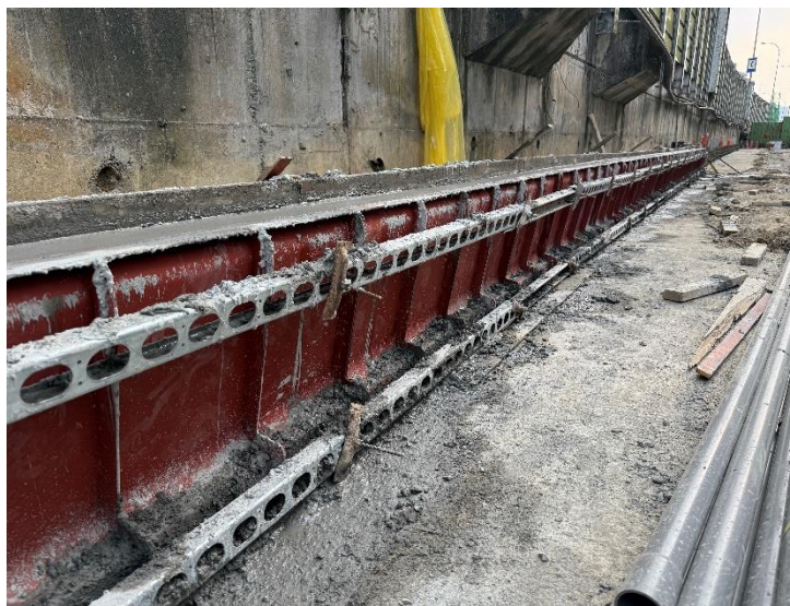
花台擋土牆施作
