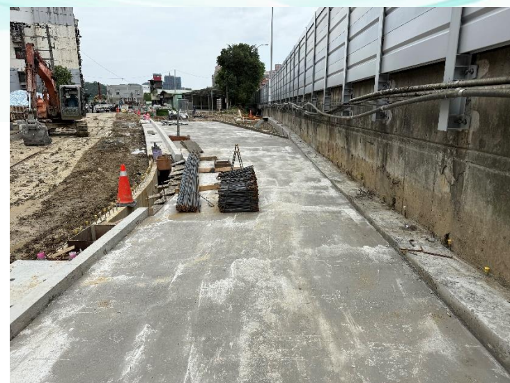
A0K+140~190人行道結構層施作
