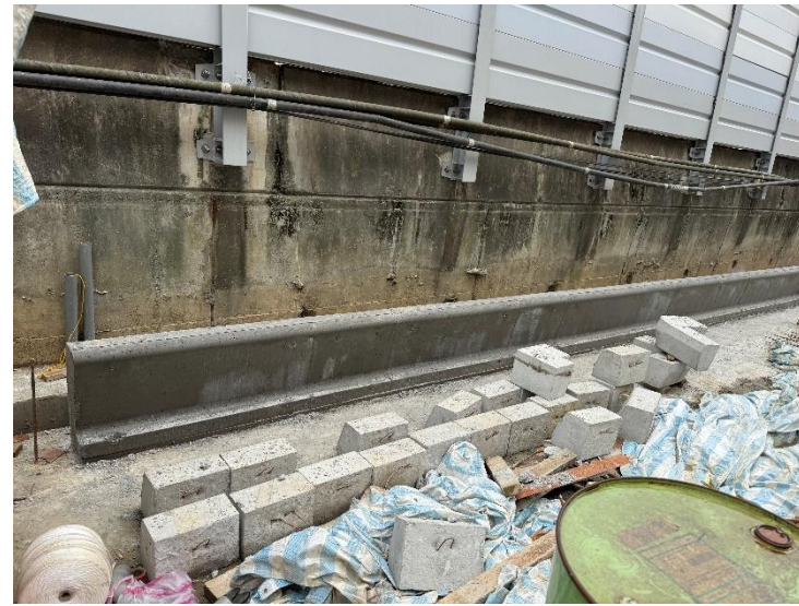
花台擋土牆施作
