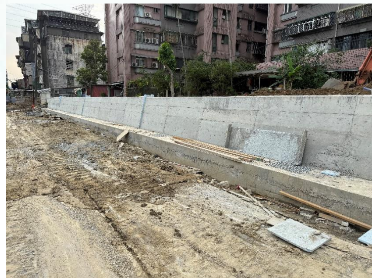
停車場擋土牆施作
