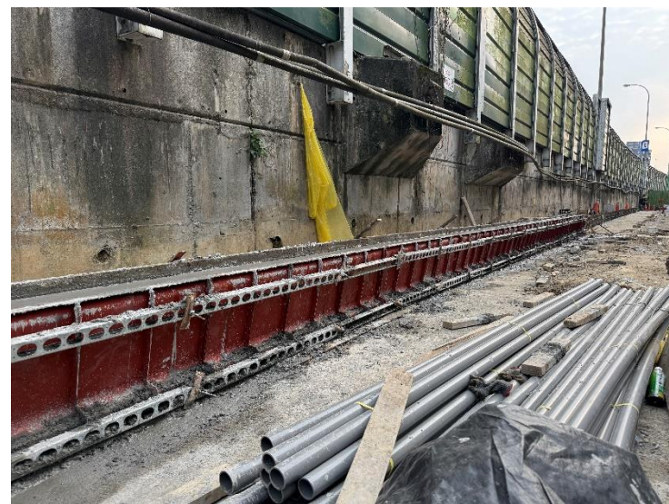
花台擋土牆施作
