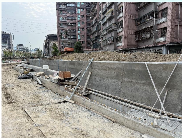
停車場擋土牆施作
