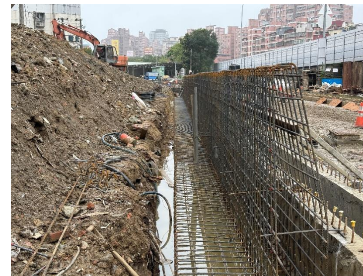
停車場擋土牆施作
