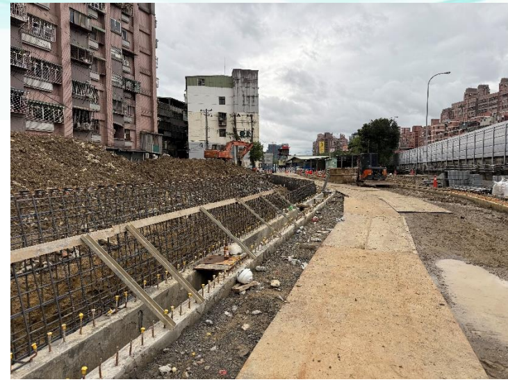
停車場擋土牆施作
