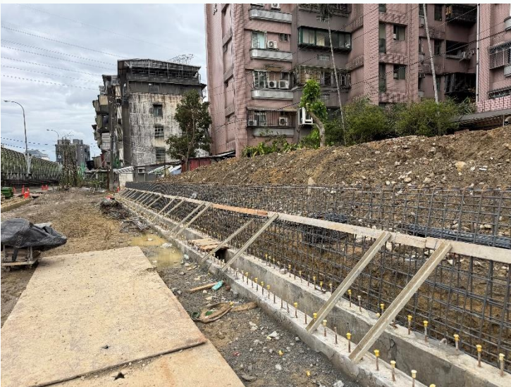
停車場擋土牆施作
