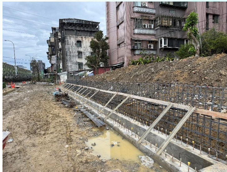
停車場擋土牆施作
