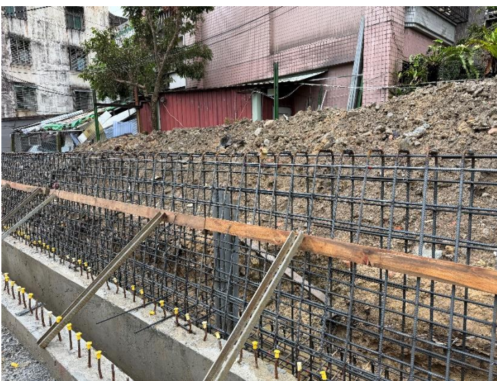
停車場擋土牆施作
