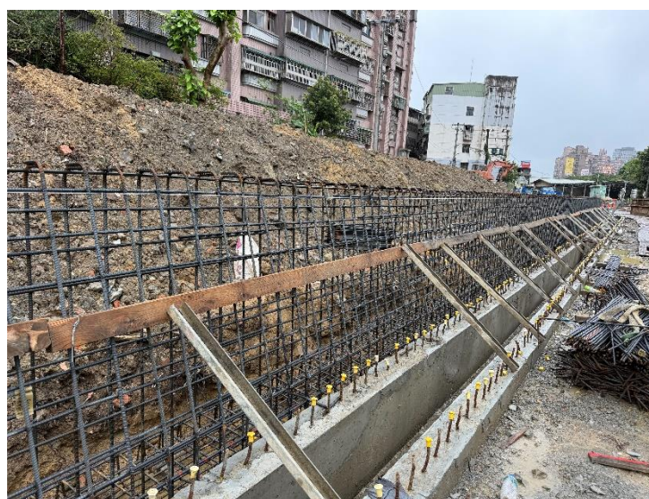
停車場擋土牆施作
