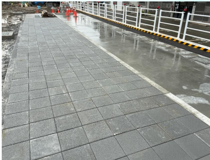
湖前街二巷高壓磚鋪設
