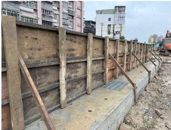
U2新設擋牆施作
