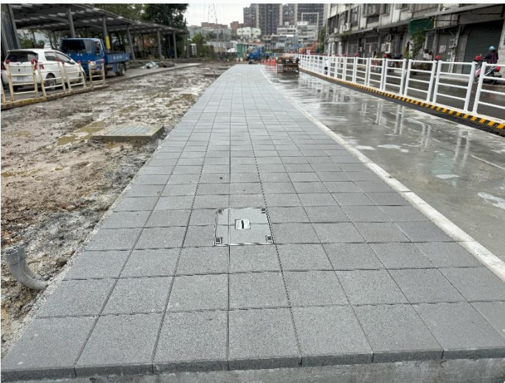
湖前街二巷高壓磚鋪設
