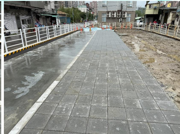
湖前街二巷高壓磚鋪設
