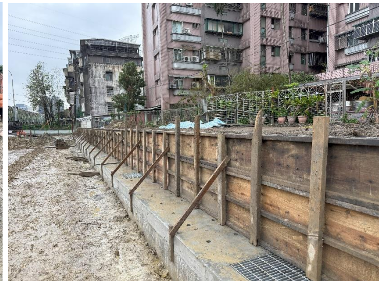
U2新設擋牆施作
