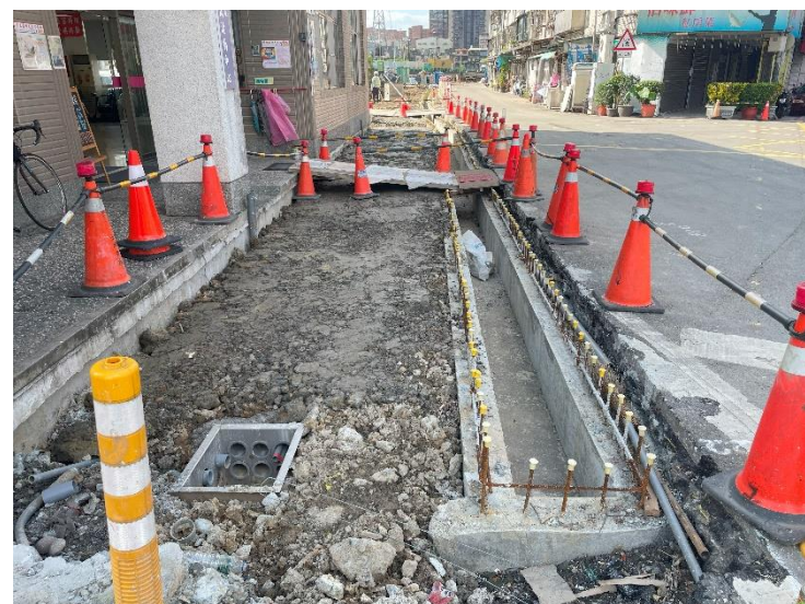
湖前街二巷弱電管溝埋設後現況
