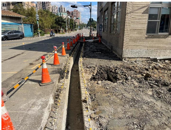
湖前街二巷弱電管溝埋設後現況
