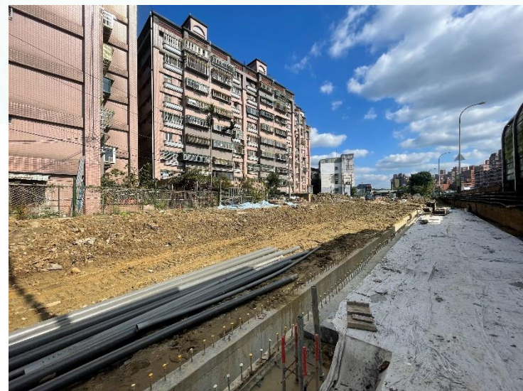
U2新設側溝整理
