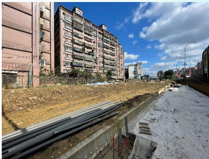
U2新設側溝整理
