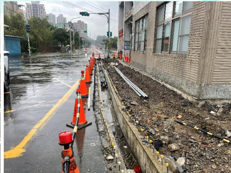
湖前街二巷弱電管溝埋設
