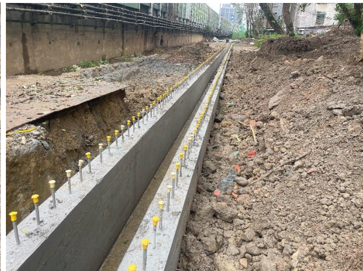
新設U3側溝施作
