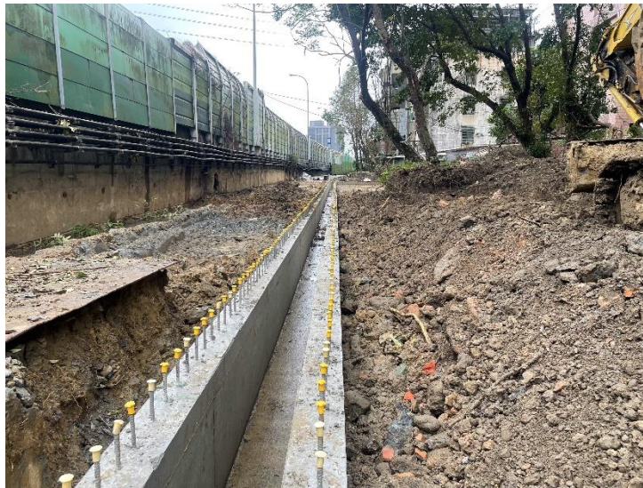
新設U3側溝施作
