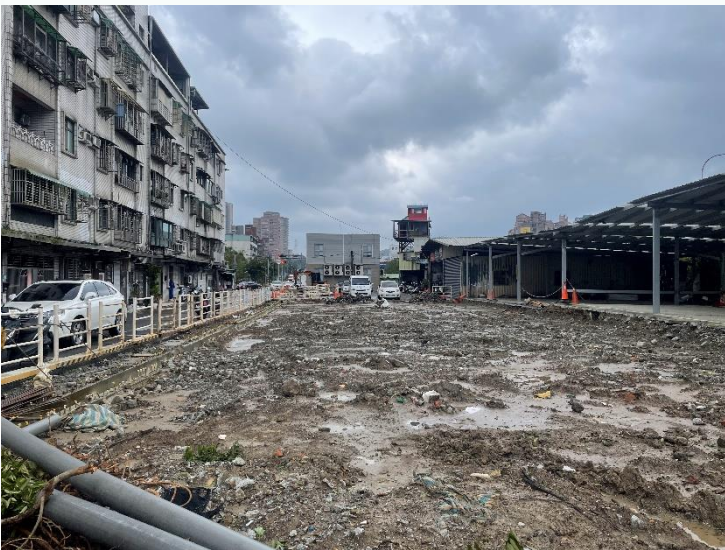
湖前街二巷土石方整理
