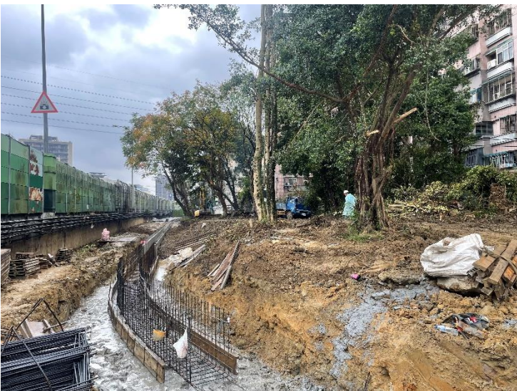
新設U3側溝施作
