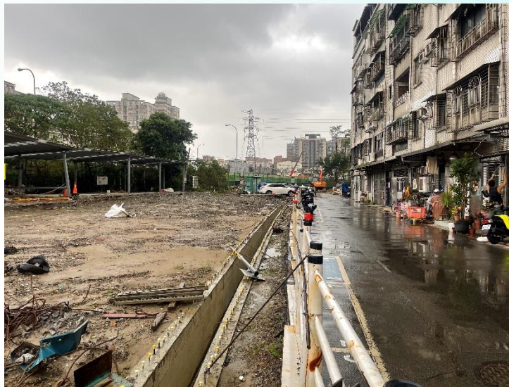
湖前街二巷土石方整理
