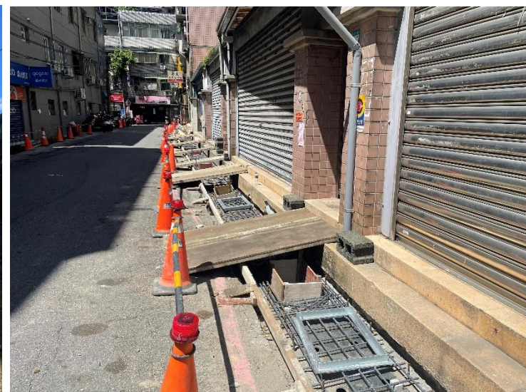
TYPE-B溝蓋板更新施作
