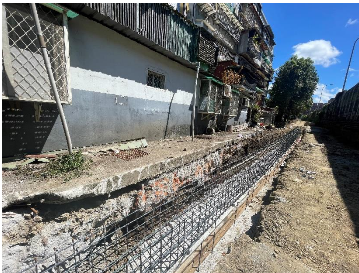
U7新設水溝鋼筋綁紮
