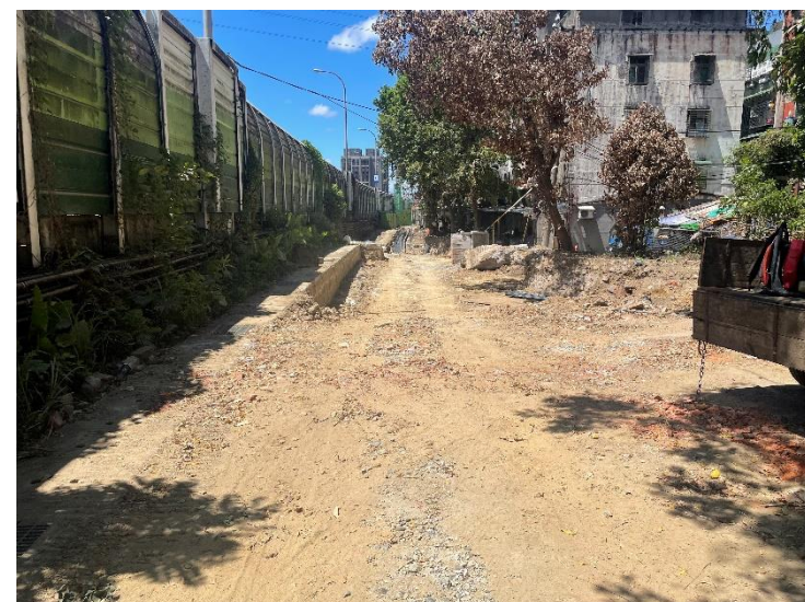
A0K+070~180土方開挖及整地
