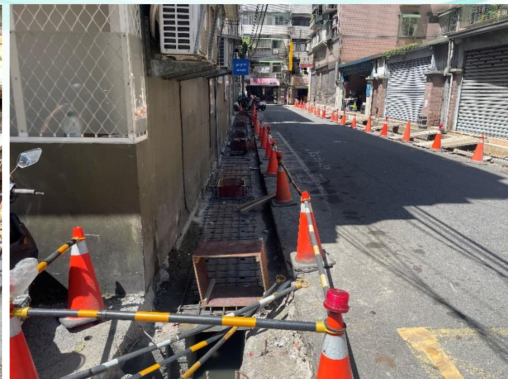
TYPE-A溝蓋板更新施作
