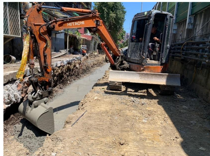
U7新設水溝PC澆置
