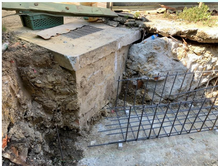
U7新設水溝鋼筋綁紮
