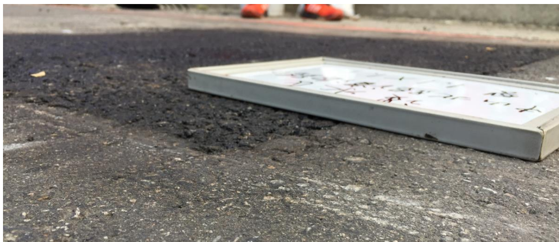
圖 6 熱再生修補新舊介面平整度檢測
