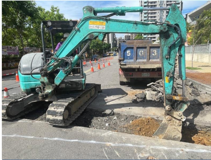
過管埋線開挖
