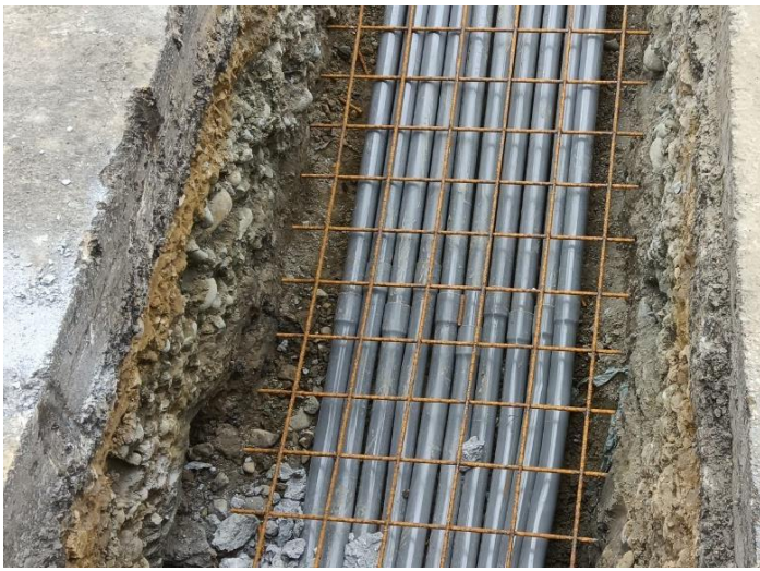
過路管線埋設
