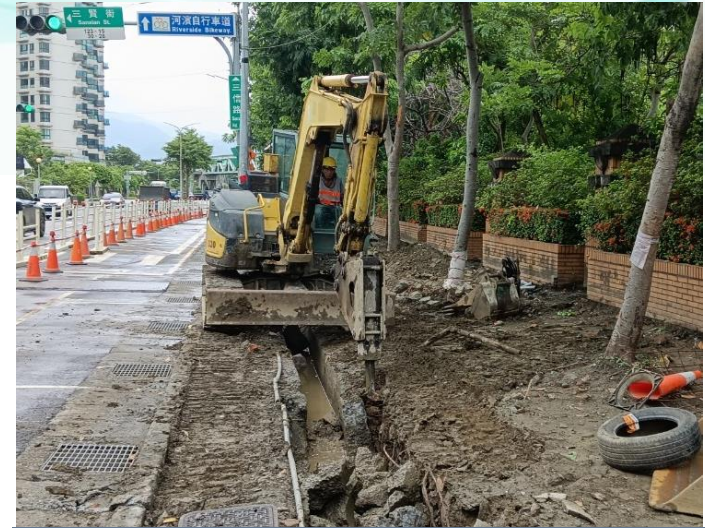
舊有洩水板開挖
