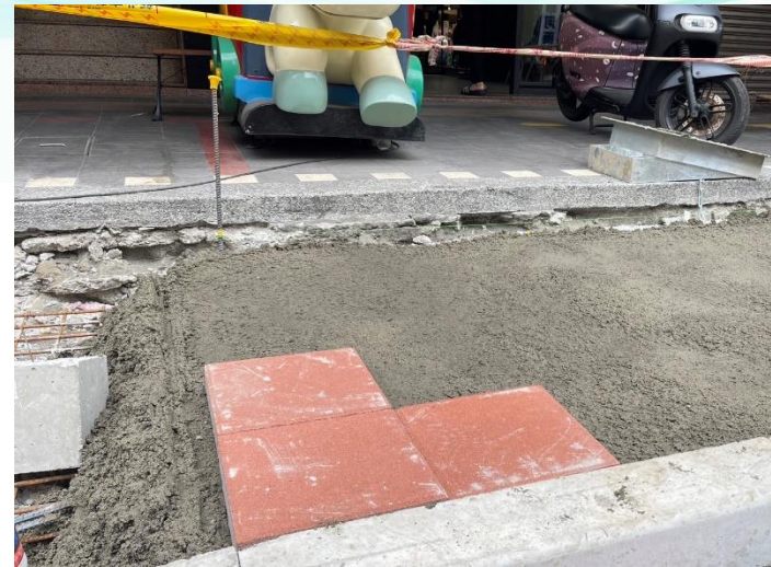
人行道工程-高壓磚、水泥砂漿
