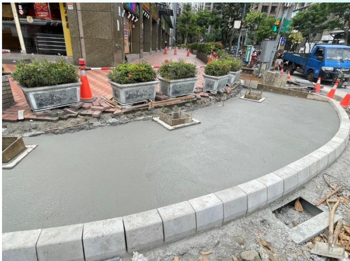
人行道工程-混凝土灌漿
