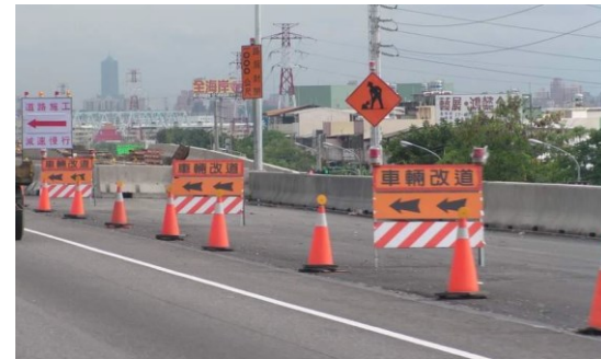
依交通維持計畫佈設交通管制設施
