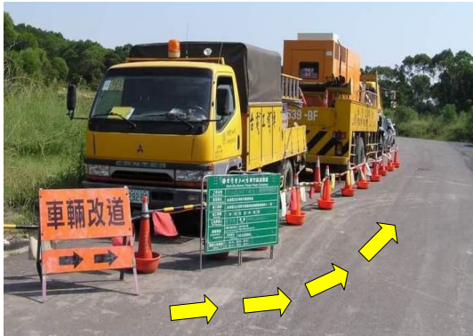
依交通維持計畫佈設交通管制設施
