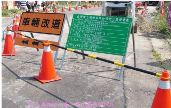
依交通維持計畫佈設交通管制設施
