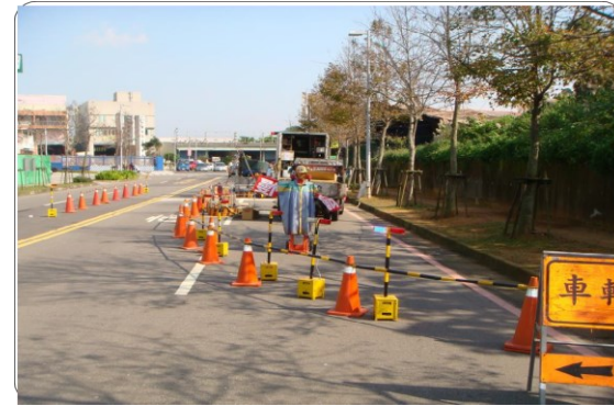
依交通維持計畫佈設交通管制設施
