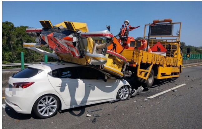
外車闖入道路施工工區 撞擊防撞裝置
