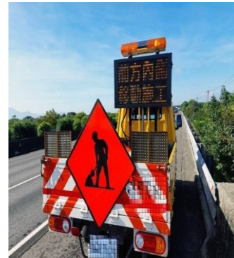
道路工程 施工工區之警示裝置
